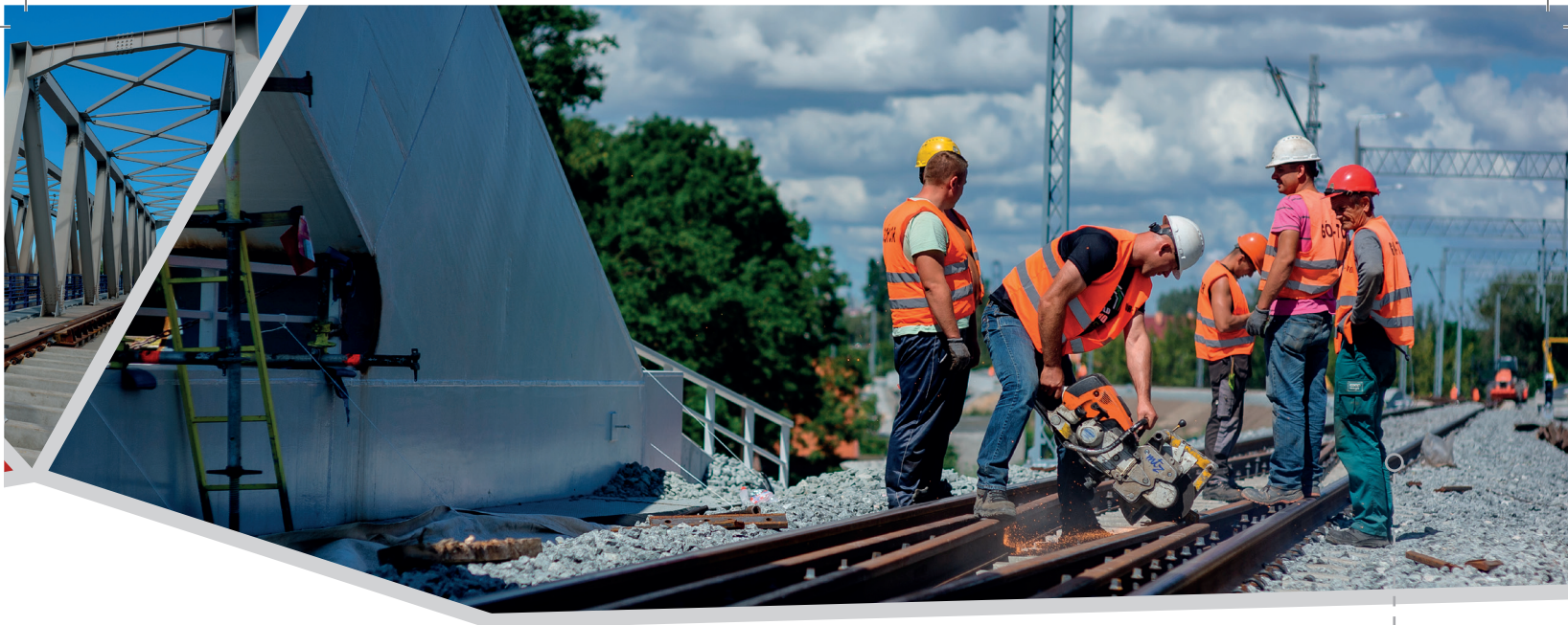
Budowa mostu na Martwej Wiśle
