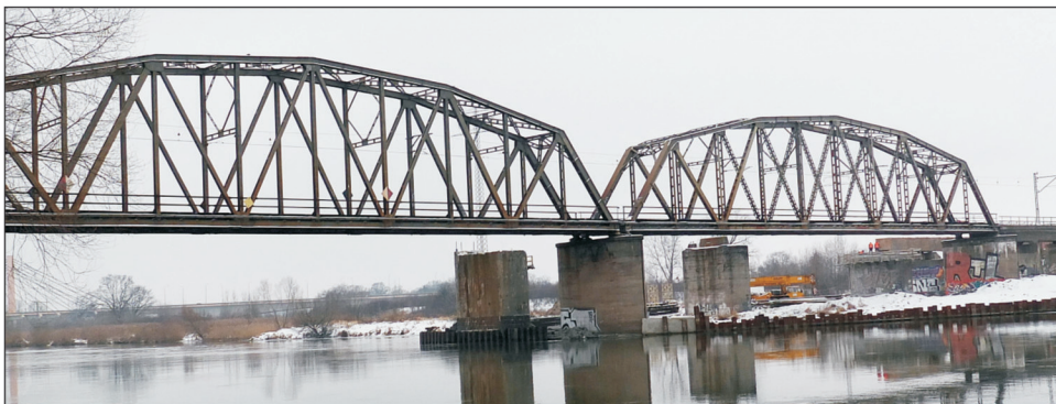
Fot. Remont mostu nad Odrą
