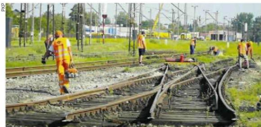
Prace już się rozpoczęły od demontażu sieci trakcyjnej i torów na zachodnim odcinku stacji
