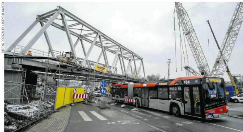
W rejonie al. Wyzwolenia trwa budowa przystanku kolejowego Rzeszów Zachodni
