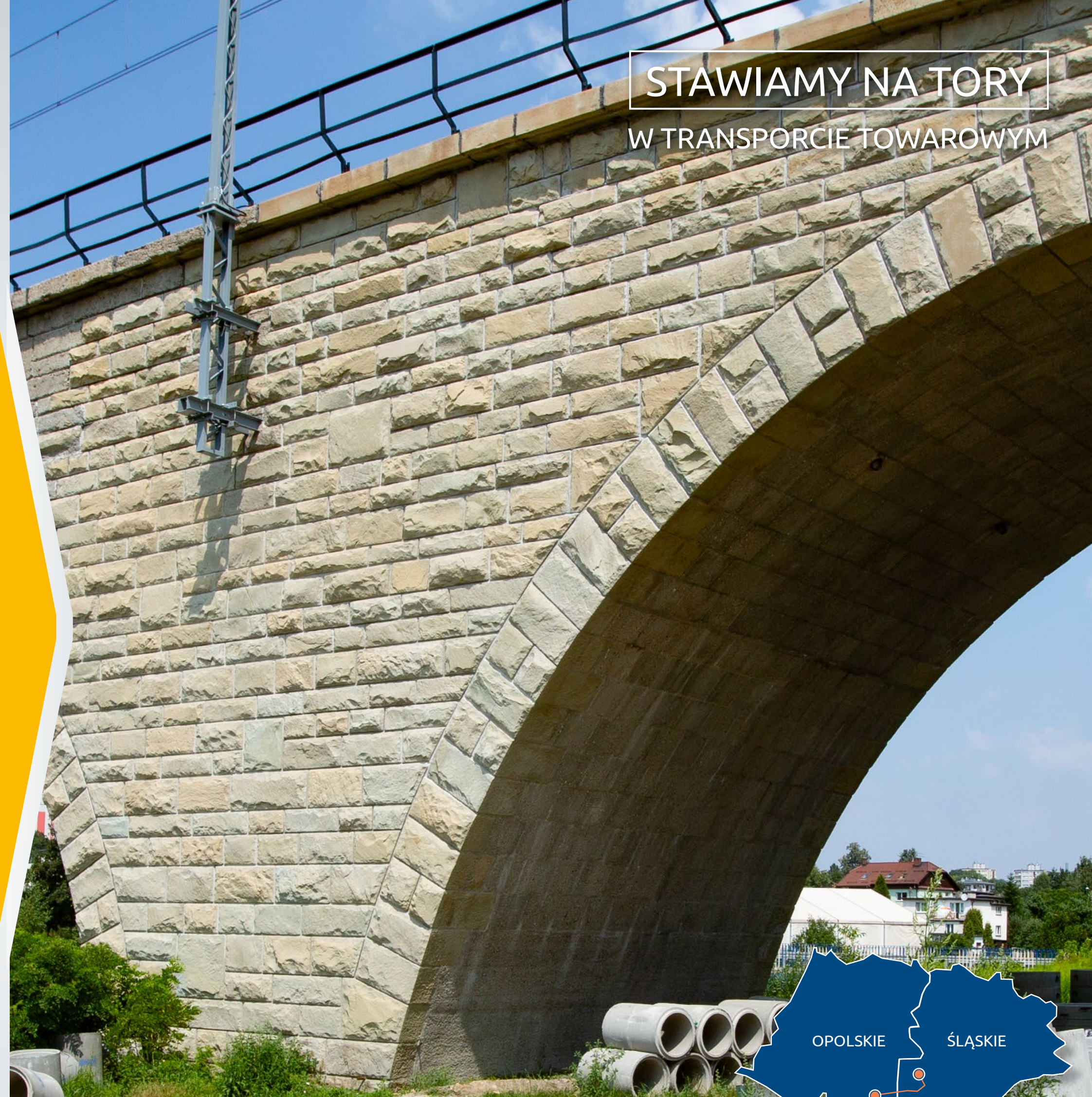
Elewacja mostu po renowacji
