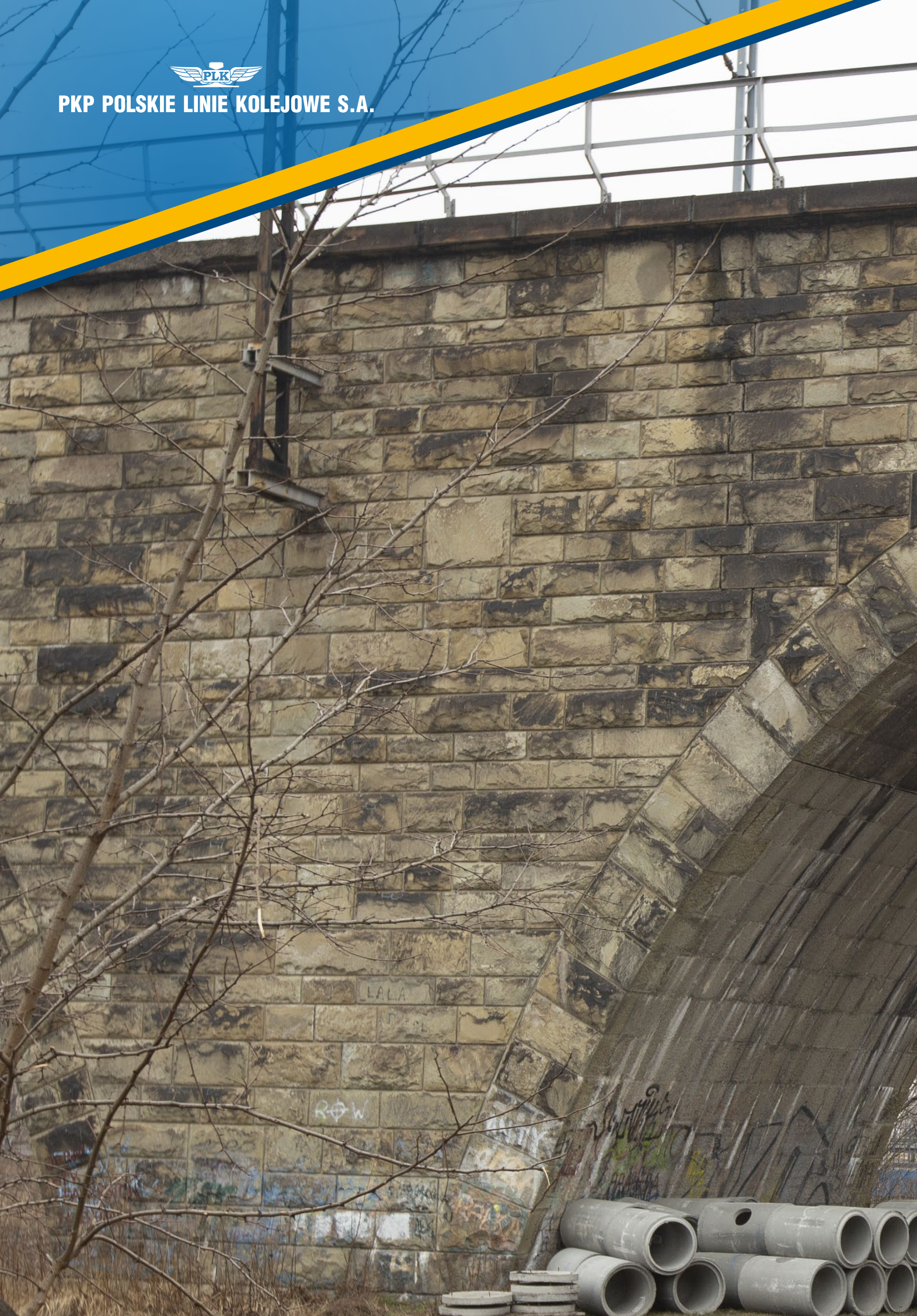
Elewacja mostu przed renowacją
