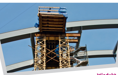
Wiadukt w Warszawie Rembertowie
