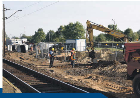
Stacja kolejowa | Stare Bojanowo
