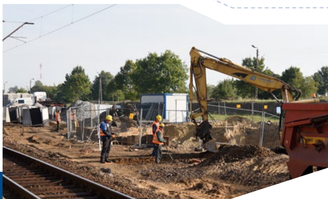
Stacja kolejowa | Stare Bojanowo
