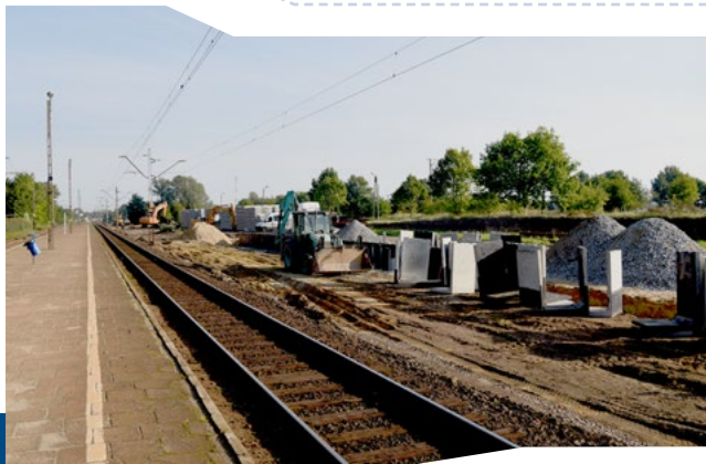
Stacja kolejowa | Stare Bojanowo
