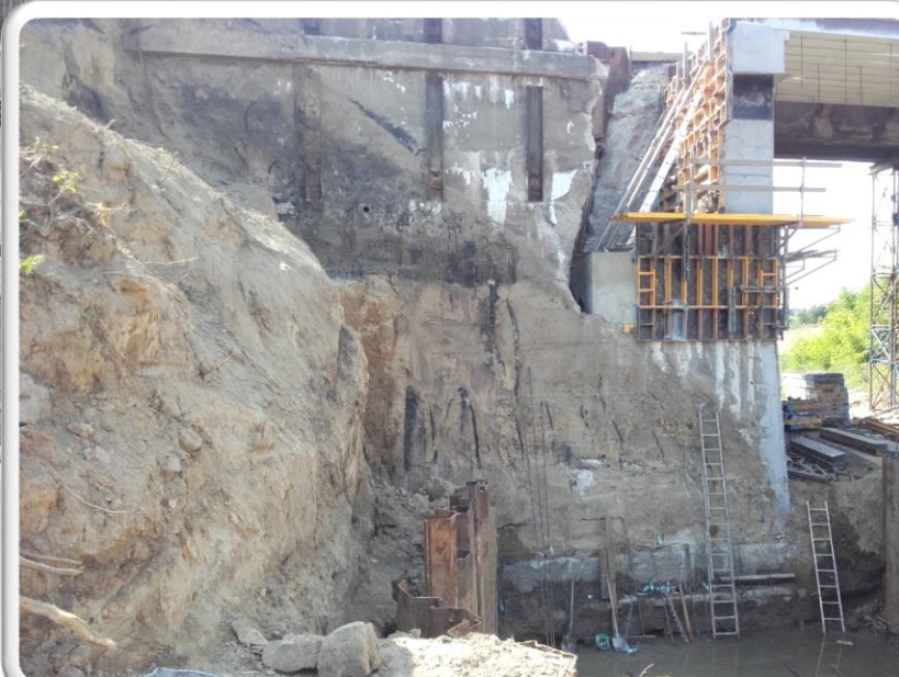
Przebudowa mostu km 26,227
