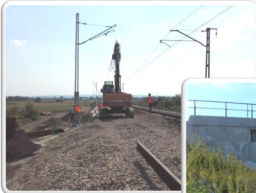
Remont wiaduktu nad ul. Podstawie km 26,354
