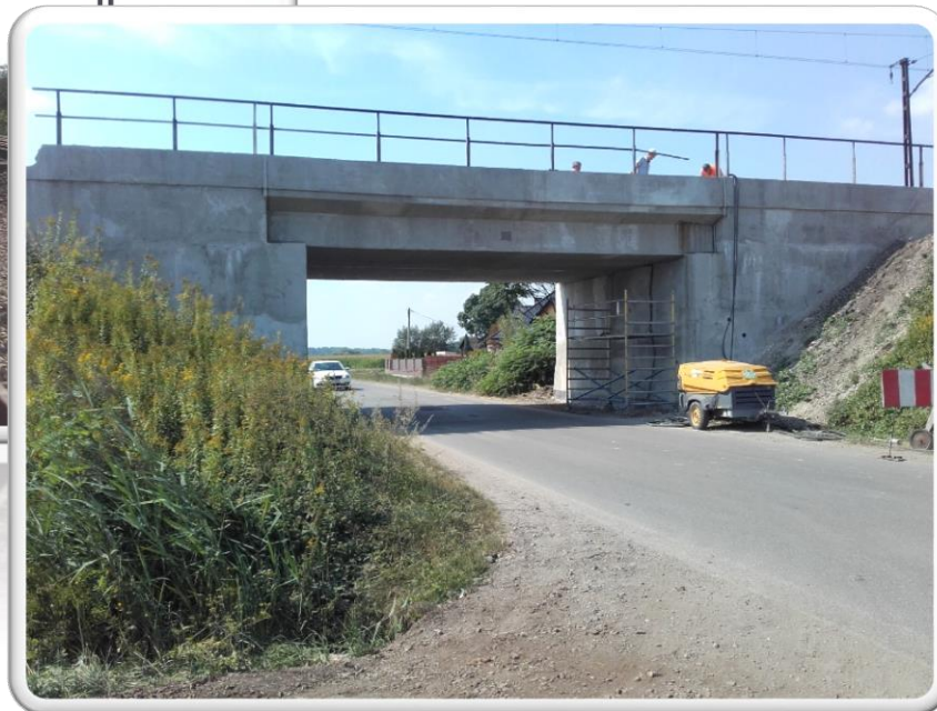
Remont wiaduktu nad ul. Drożyska km 27,034
