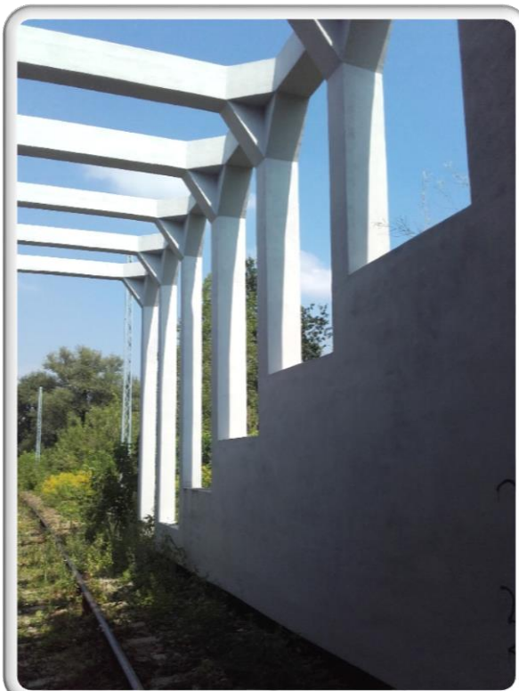
Remont wiaduktu km 31,802
