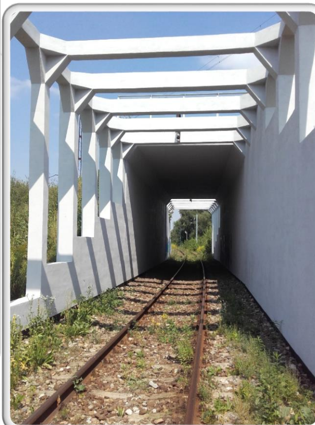
Remont wiaduktu km 31,802
