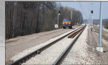
Odcinek Pęgów - Oborniki Śląskie
