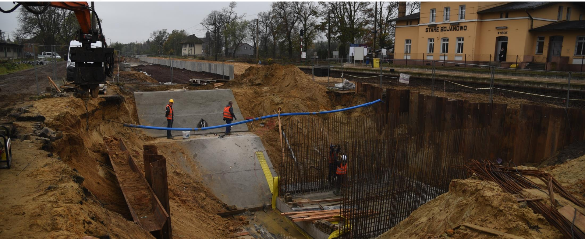
STACJA KOLEJOWA STARE BOJANOWO
