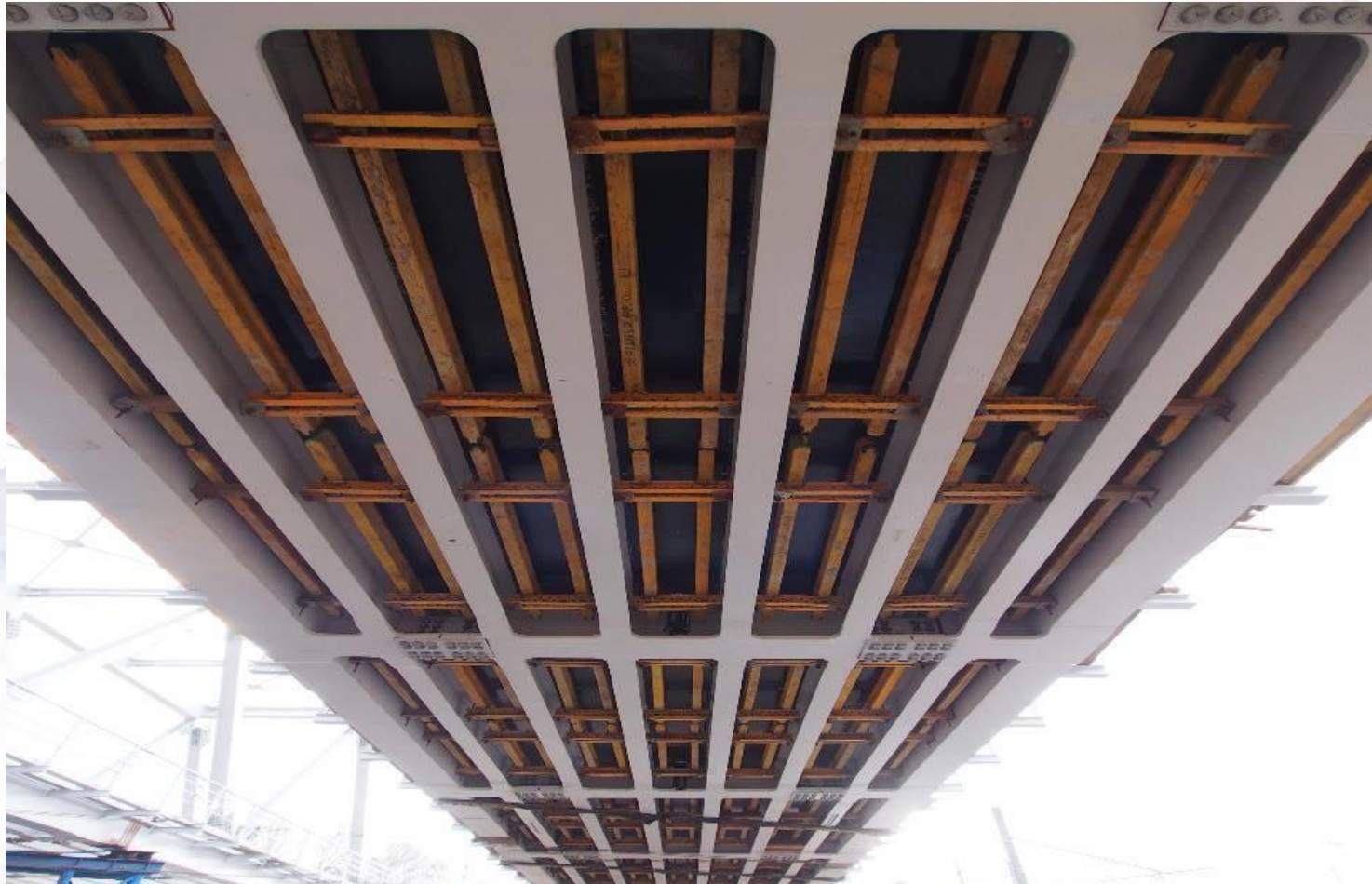
WIADUKT, UL. WOLSKA – DESKOWANIE KONSTRUKCJI STAŁOWEJ WIADUKTU POD BETONOWANIE USTROJU; 20.11.2017 r.
