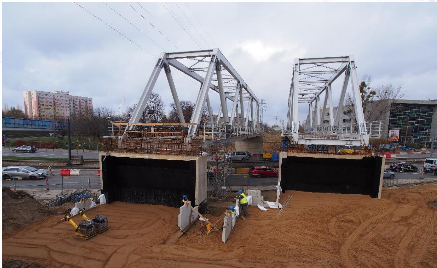
WIADUKT, UL. WOLSKA – MONTAŻU KONSTRUKCJI STALOWEJ WIADUKTU Z PODPÓR TYMCZASOWYCH NA NOWE PODPORY OBIEKTU, PRACE PRZY MURACH OPOROWYCH OBIEKTU WRAZ Z ZASYPKAMI
