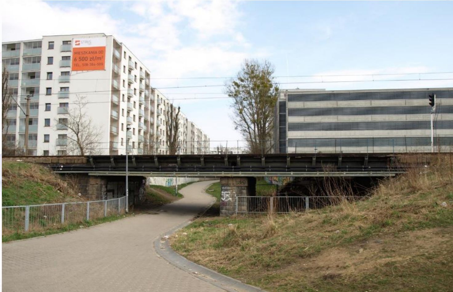
WIADUKT PRZED PRZEBUDOWĄ NAD PRZEJŚCIEM DLA PIESZCHY – UL. ZAWISZY LINIA KOLEJOWA NR 20 KM 7,173
