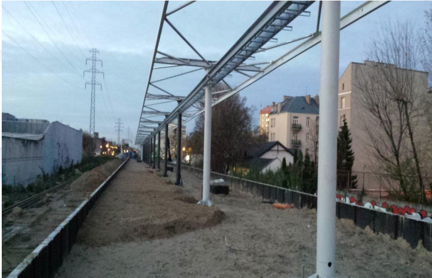
PRZYSTANEK OSOBOWY WARSZAWA WOLA (DAWNIEJ KASPRZAKA) – MONTAŻ KONSTRUKCJI STALOWEJ ZADASZENIA WIAT PERONOWYCH; 02.11.2017 r.
