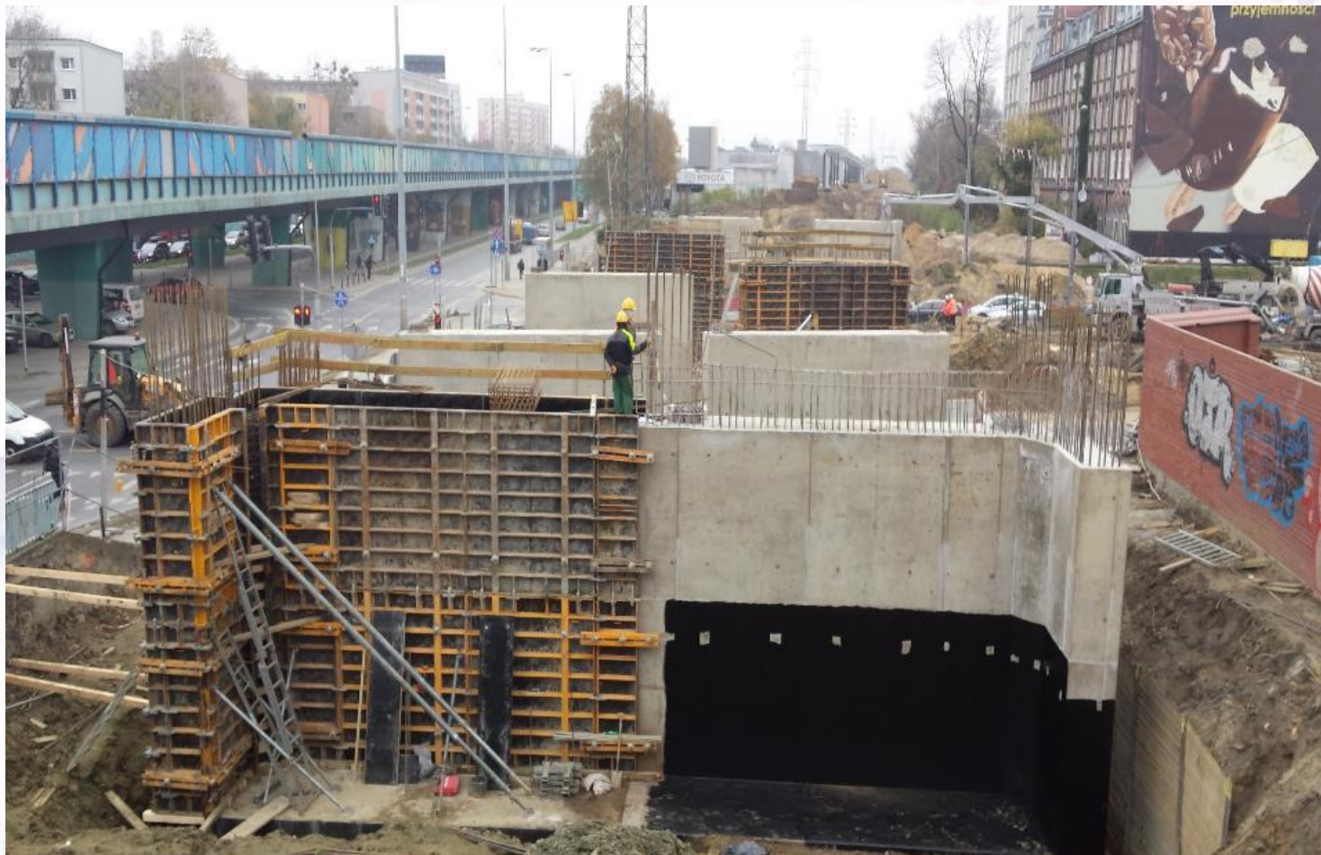
WIADUKT UL. KASPRZAKA – BETONOWANIE PODPÓR
