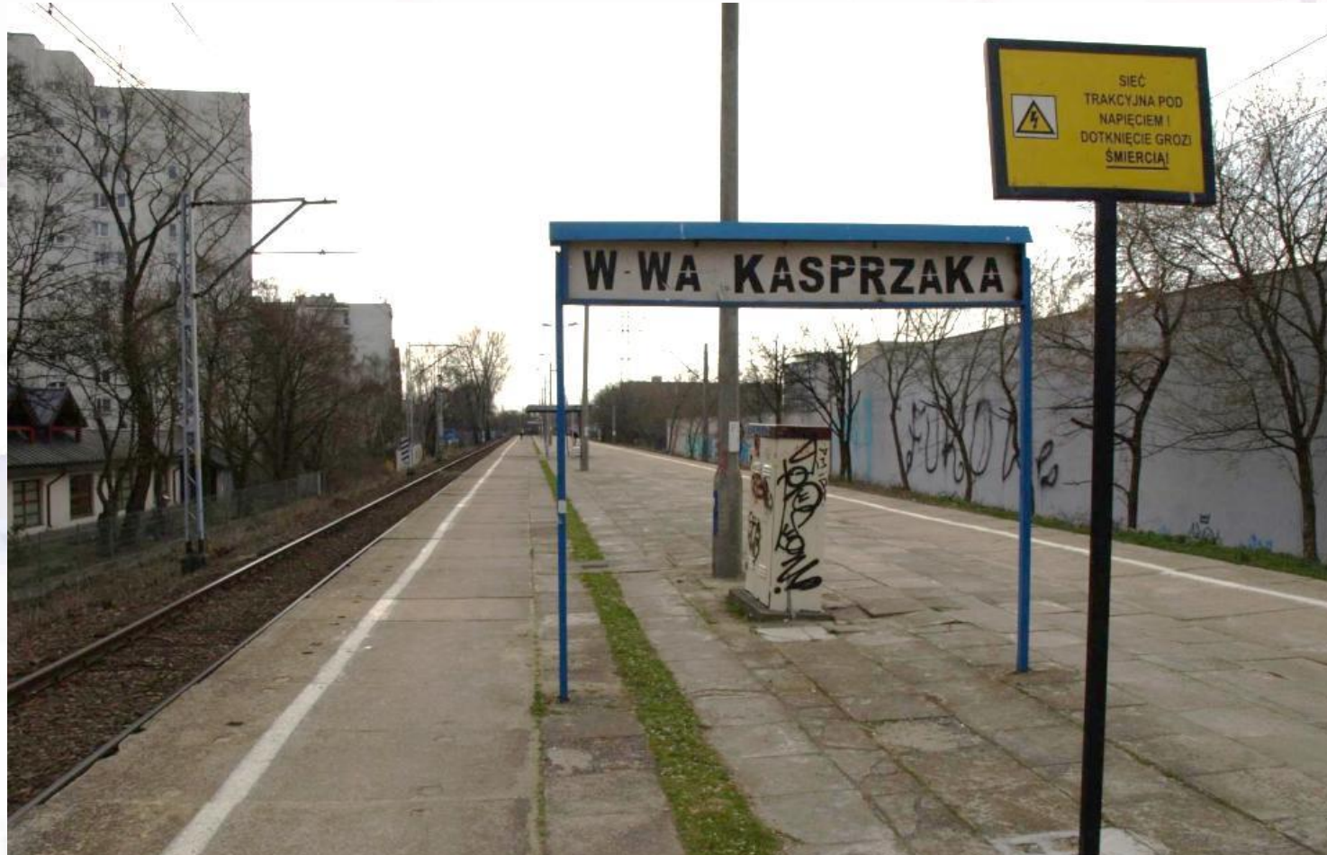
PRZYSTANEK OSOBOWY WARSZAWA WOLA (DAWNIEJ KASPRZAKA) – PRZED PRZEBUDOWĄ
