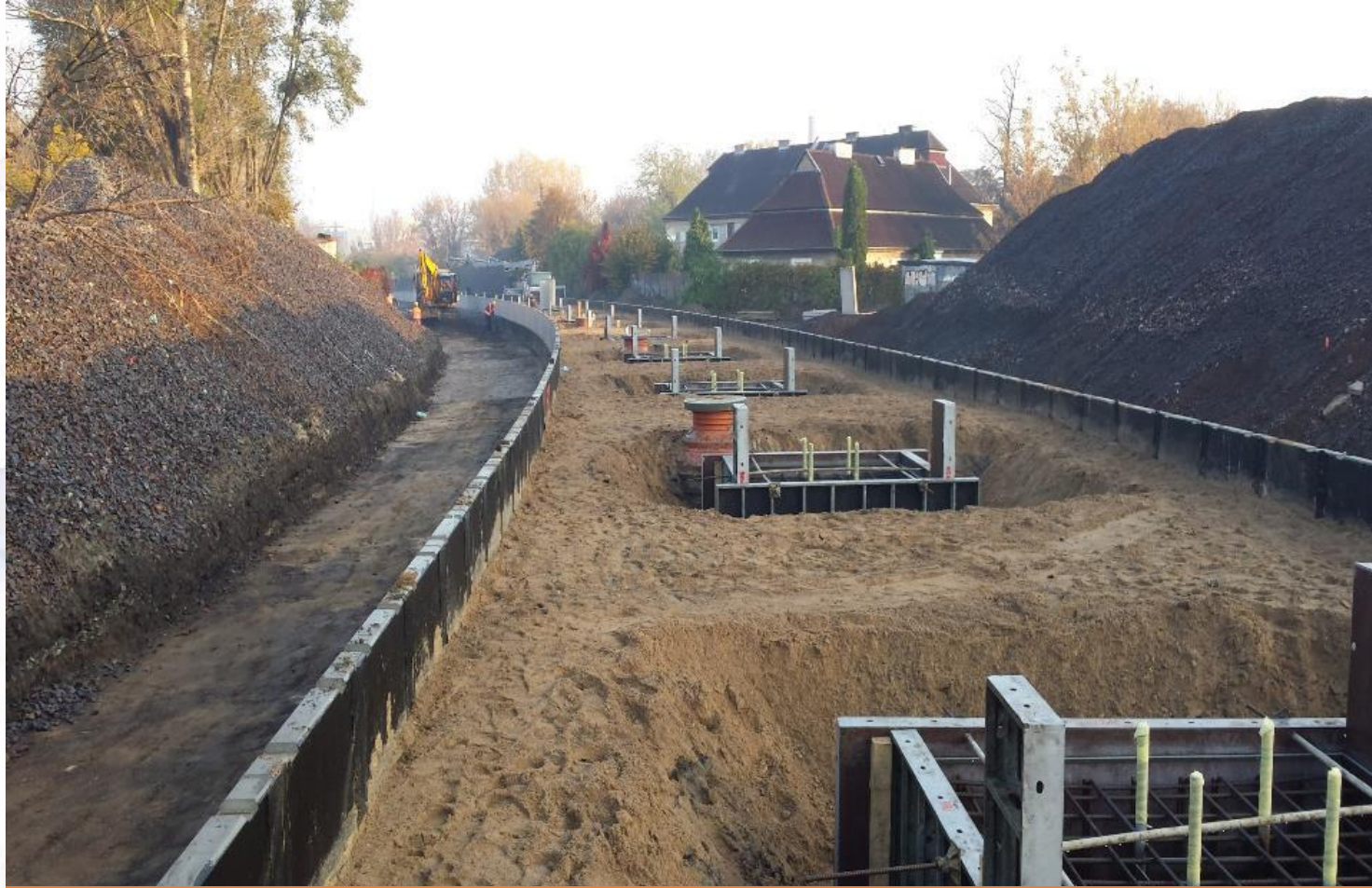
WYKONANE ZASYPKI PERONOWE ORAZ DESKOWANIE STÓP FUNDAMENTOWYCH PERONU NR 8 NA STACJI WARSZAWA ZACHODNIA PRZY TORZE NR 2; 02.11.2017r.
