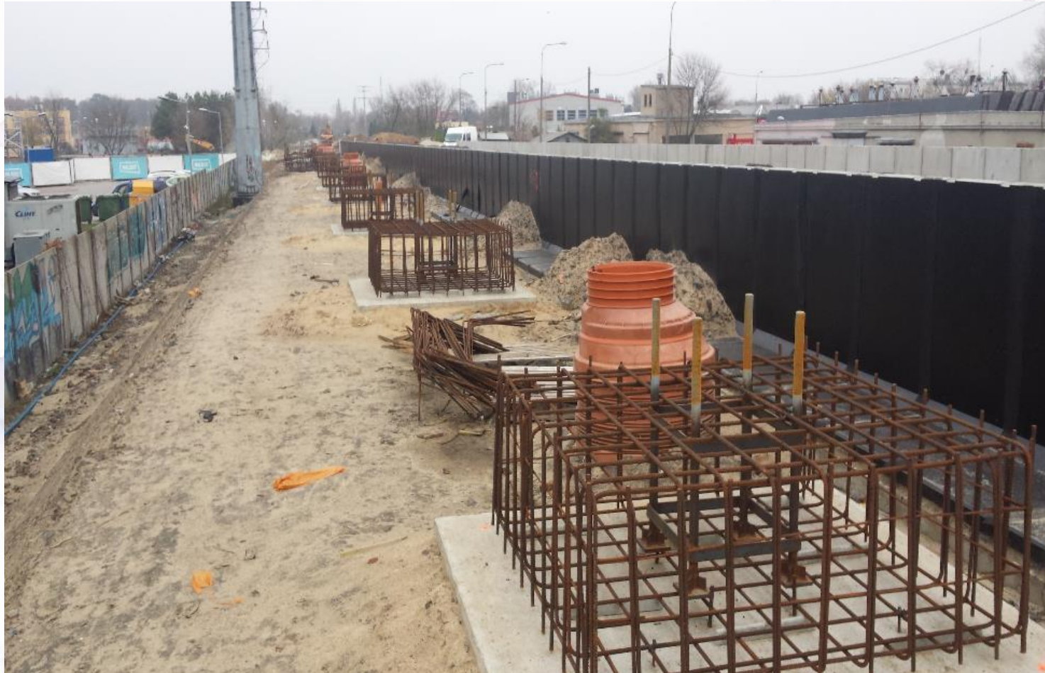
PRZYSTANEK WARSZAWA OBOZOWA – ZBROJENIE STÓP FUNDAMENTOWYCH; 20.11.2017 r.
