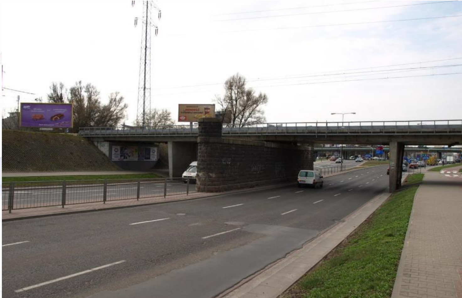
WIADUKT PRZED BUDOWĄ KŁADEK DLA PIESZYCH NAD UL. GÓRCZEWSKĄ LINIA KOLEJOWA NR 20 KM 6,429
