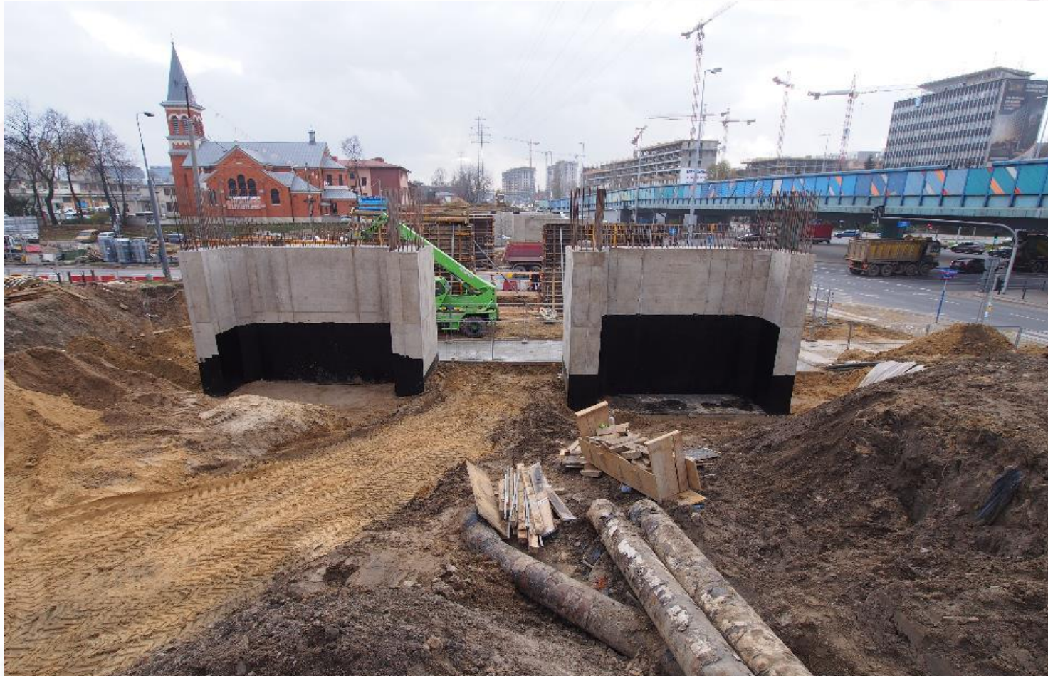
WIADUKT UL. KASPRZAKA – PRZYGOTOWANIE DESKOWANIA PODPÓR POD BETONOWANIE; 20.11.2017 r.
