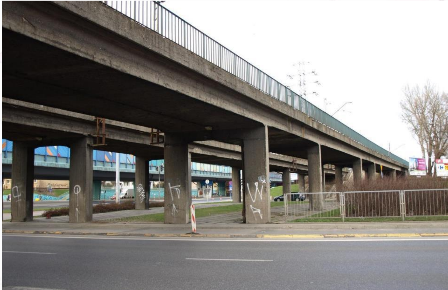
WIADUKT PRZED PRZEBUDOWĄ NAD UL. KASPRZAKA LINIA KOLEJOWA NR 20 KM 5,327
