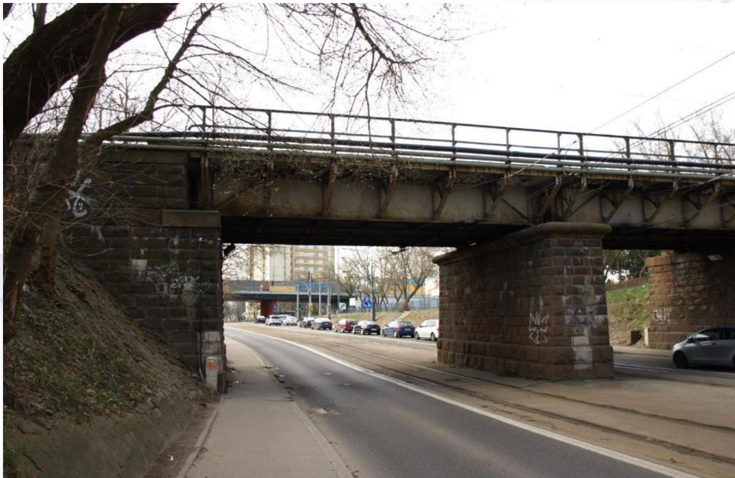
WIADUKT PRZED PRZEBUDOWĄ NAD UL. OBOZOWĄ LINIA KOLEJOWA NR 20 KM 7,505
