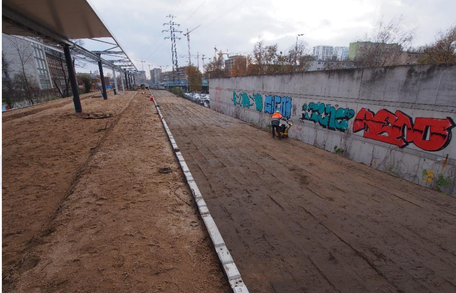
P. O. WARSZAWA WOLA (DAWNIEJ KASPRZAKA) – MONTAŻ ZADASZENIA KONSTRUKCJI STALOWEJ WIAT PERONOWYCH ORAZ WYKONANO ZASYPKI PERONOWE; 20.11.2017 r.
