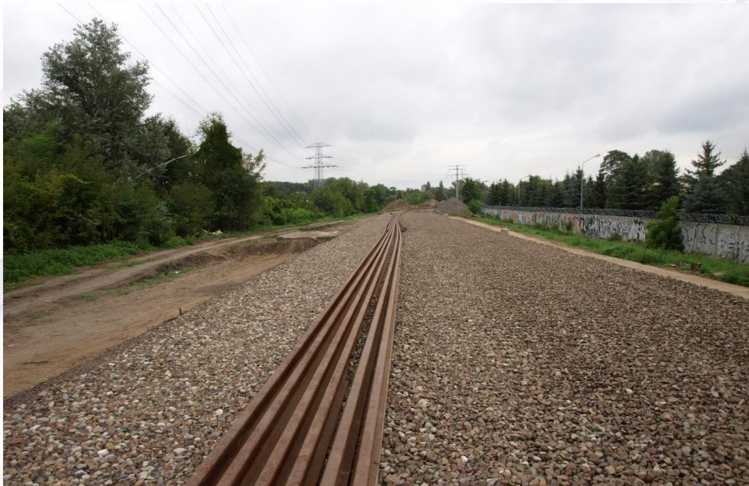
LINIA KOLEJOWA NR 20, OD STRONY UL. OBOZOWEJ W STRONĘ UL. GDAŃSKIEJ, PRZYGOTOWANIE PODTORZA
