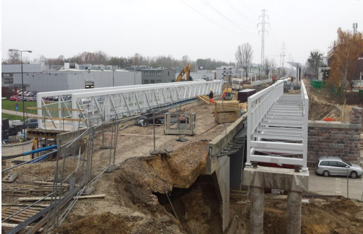
KŁADKA DLA PIESZYCH UL. GÓRCZEWSKA – MONTAŻ KONSTRUKCJI STALOWYCH KŁADKI
