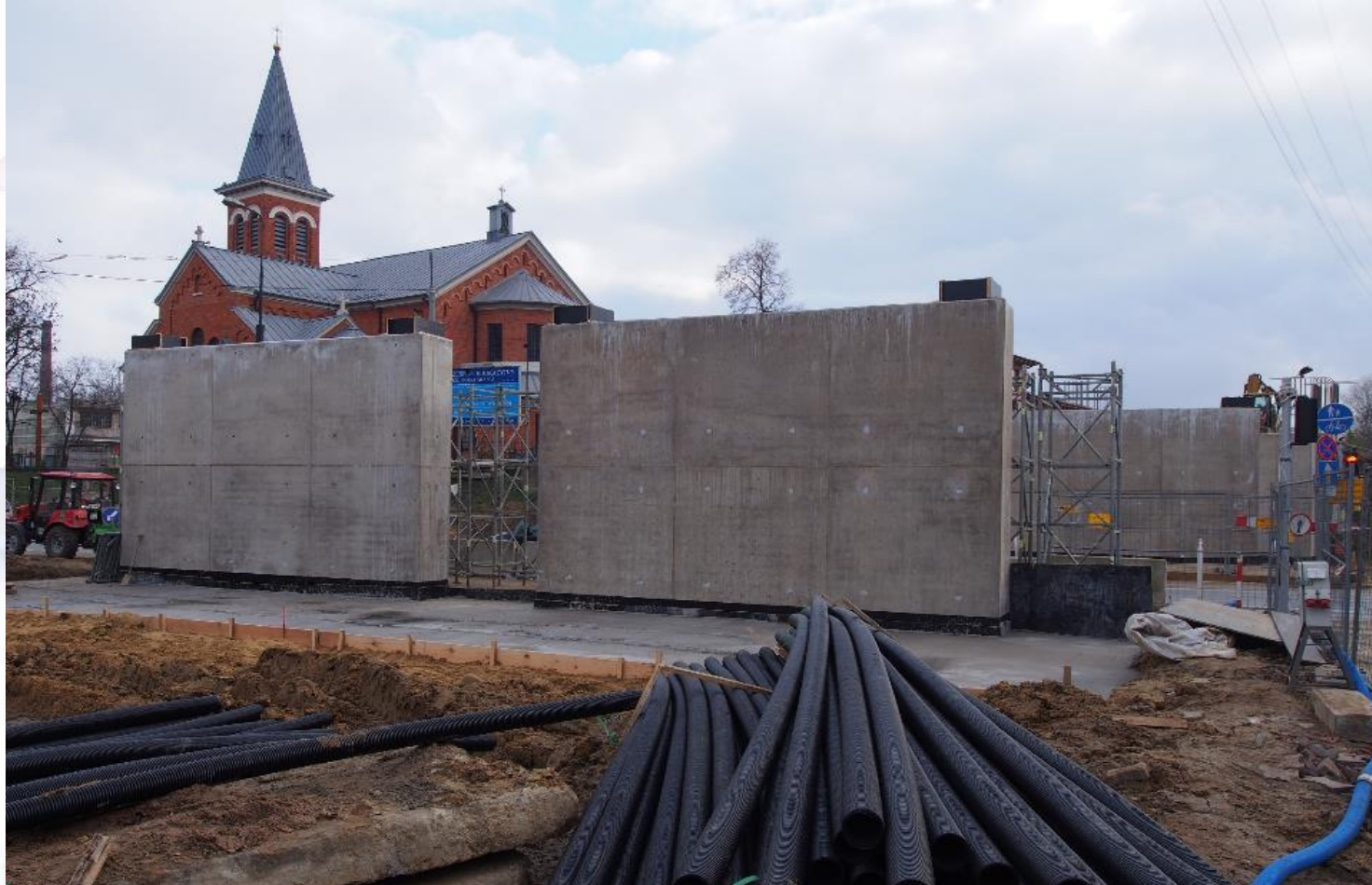
WIADUKT UL. KASPRZAKA – BETONOWANIE PODPÓR POD USTRÓJ NOŚNY
