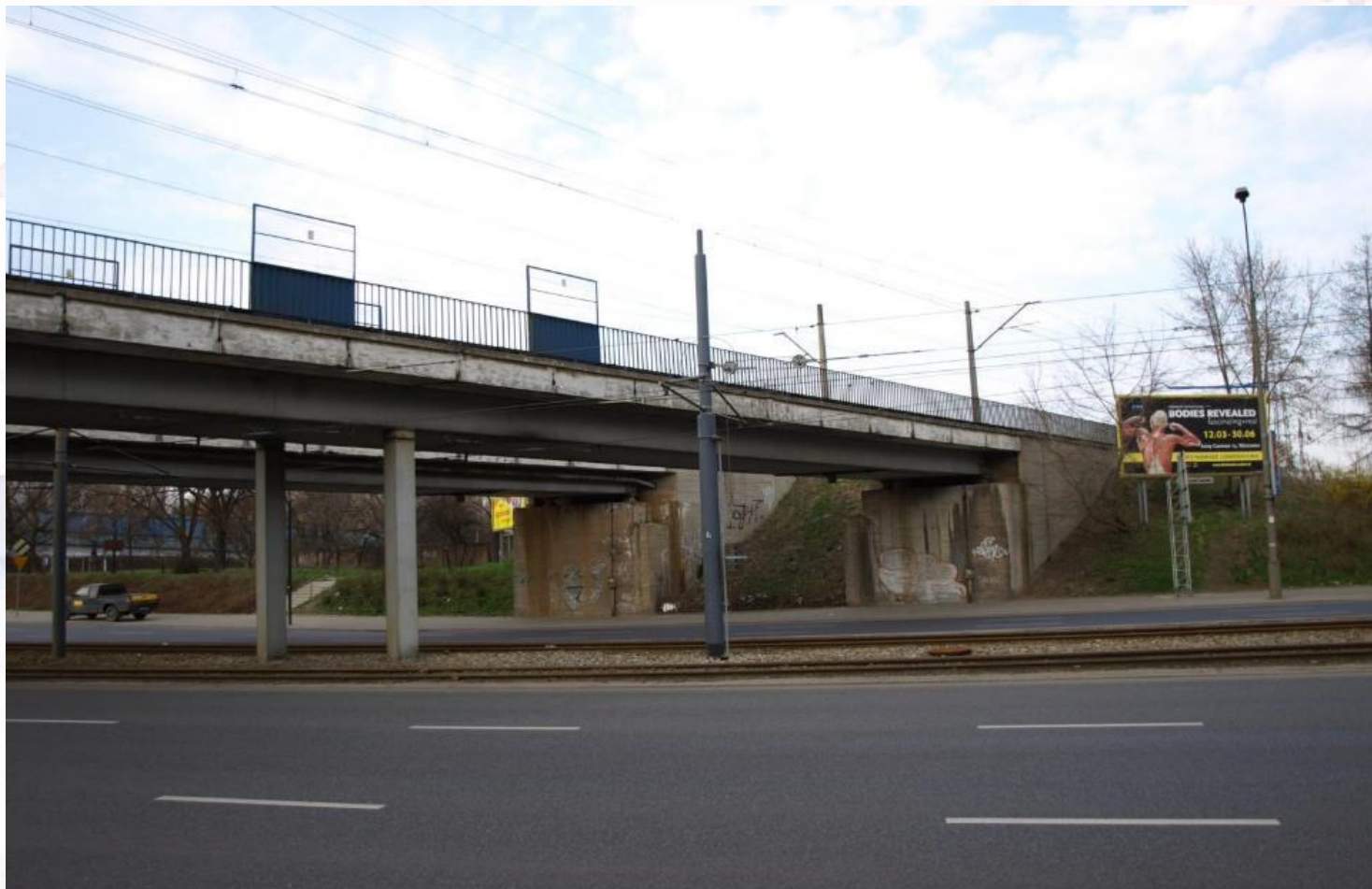
WIADUKT PRZED PRZEBUDOWĄ NAD UL. WOLSKĄ LINIA KOLEJOWA NR 20 KM 5,732
