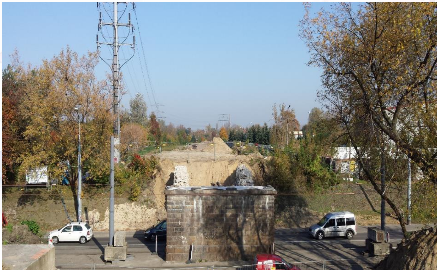
LINIA KOLEJOWA NR 20 WIADUKT NAD UL. OBOZOWĄ, WSTRZYMANE PRAC NA WNIOSEK KONSERWATORA ZABYTEKÓW. ZABETONOWANIE ŁAWY PODŁOŻYSKOWEJ PODPORY ŚRODKOWEJ.
