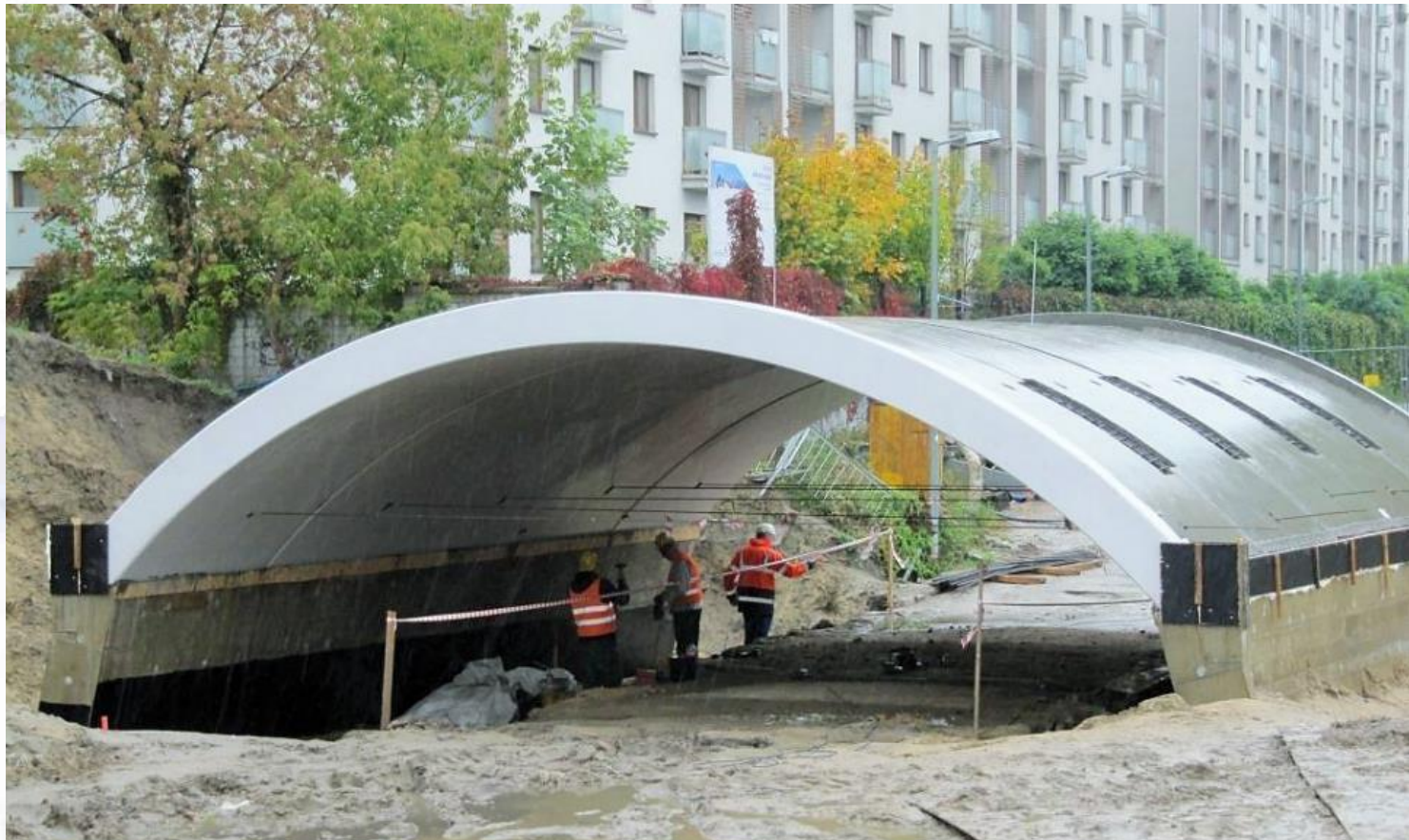
WIADUKT, UL. ZAWISZY – WYKONANIE PODPÓR ORAZ MONTAŻ USTROJU NOŚNEGO WIADUKTU
