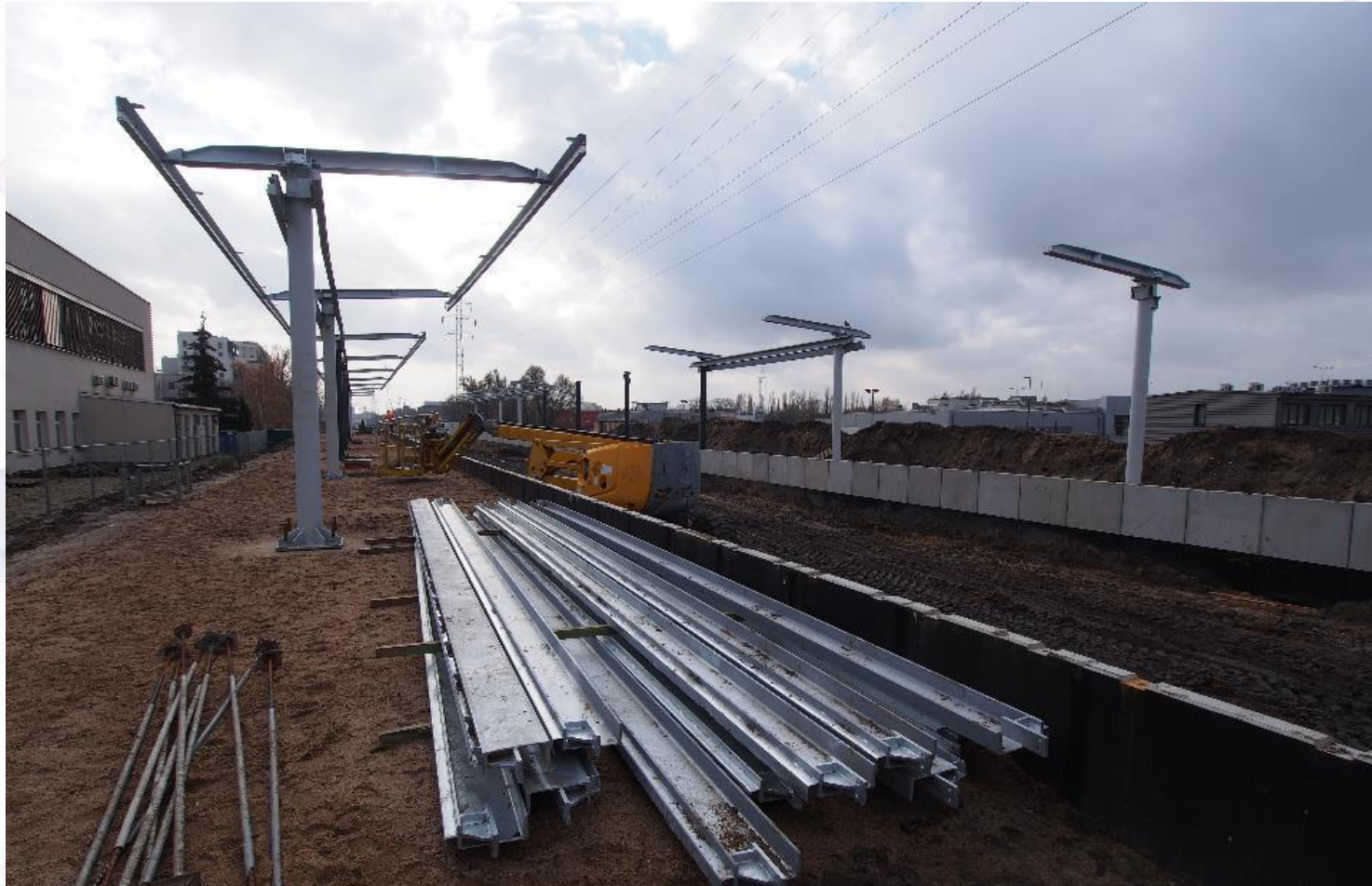
P.O. WARSZAWA MŁYNÓW (DAWNIEJ KOŁO) – MONTAŻ KONSTRUKCJI STALOWEJ WIAT PERONOWYCH; 20.11.2017 r.
