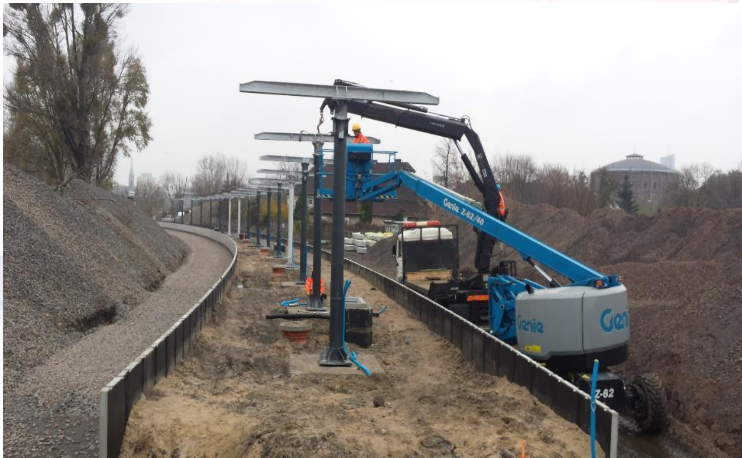
ZABETONOWANIE STÓP FUNDAMENTOWYCH ORAZ MONTAŻ SŁUPÓW WRAZ Z KONSTRUKCJĄ STAŁOWĄ ZADASZENIA WIATY PERONU NR 8 NA STACJI WARSZAWA ZACHODNIA PRZY TORZE NR 2; 20.11.2017r.
