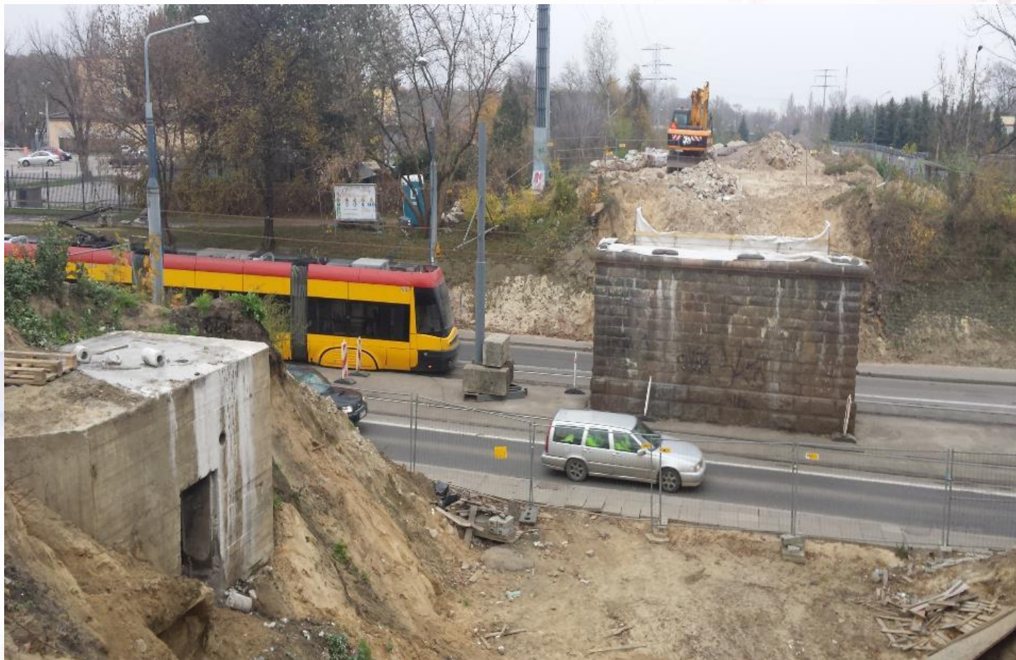
LINIA KOLEJOWA NR 20 WIADUKT NAD UL. OBOZOWĄ WSTRZYMANIE PRAC NA WNIOSEK KONSERWATORA ZABYTEKÓW; 15.11.2017 r.
