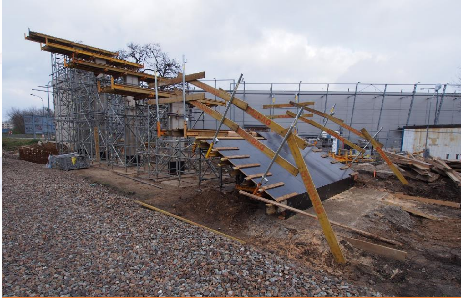
NOWOPROJEKTOWANA KŁADKA NA UL. PRĄDZYŃSKIEGO – PRZYGOTOWANIE SZALUNKÓW POD SCHODY KŁADKI; 20.11.2017
