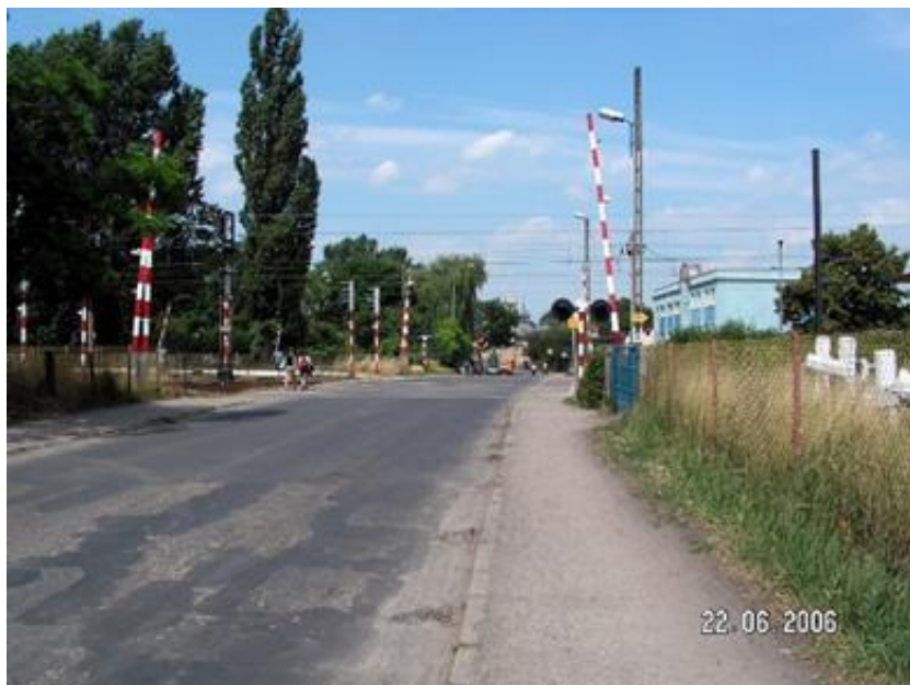
1. Wiadukt kolejowy nad ulicą Młyńską w Kościanie (km 122,952 linii kolejowej)
