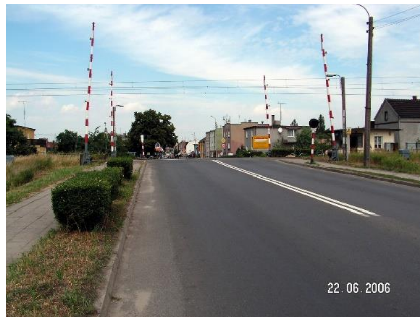
2. Wiadukt kolejowy nad ulicą Gostyńską w Kościanie (km 123,903 linii kolejowej)
