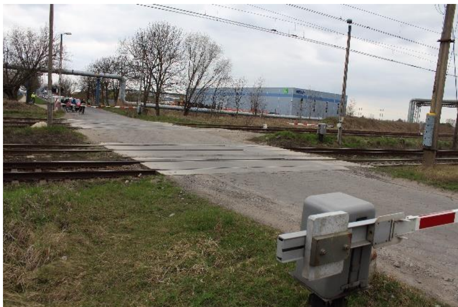
1. w ciągu ulicy Wilkowickiej w Lesznie (km 97,749 linii E59)
