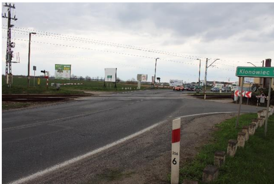
2. w ciągu drogi krajowej DK5 w Klonówcu (km 102,026 linii E59)
